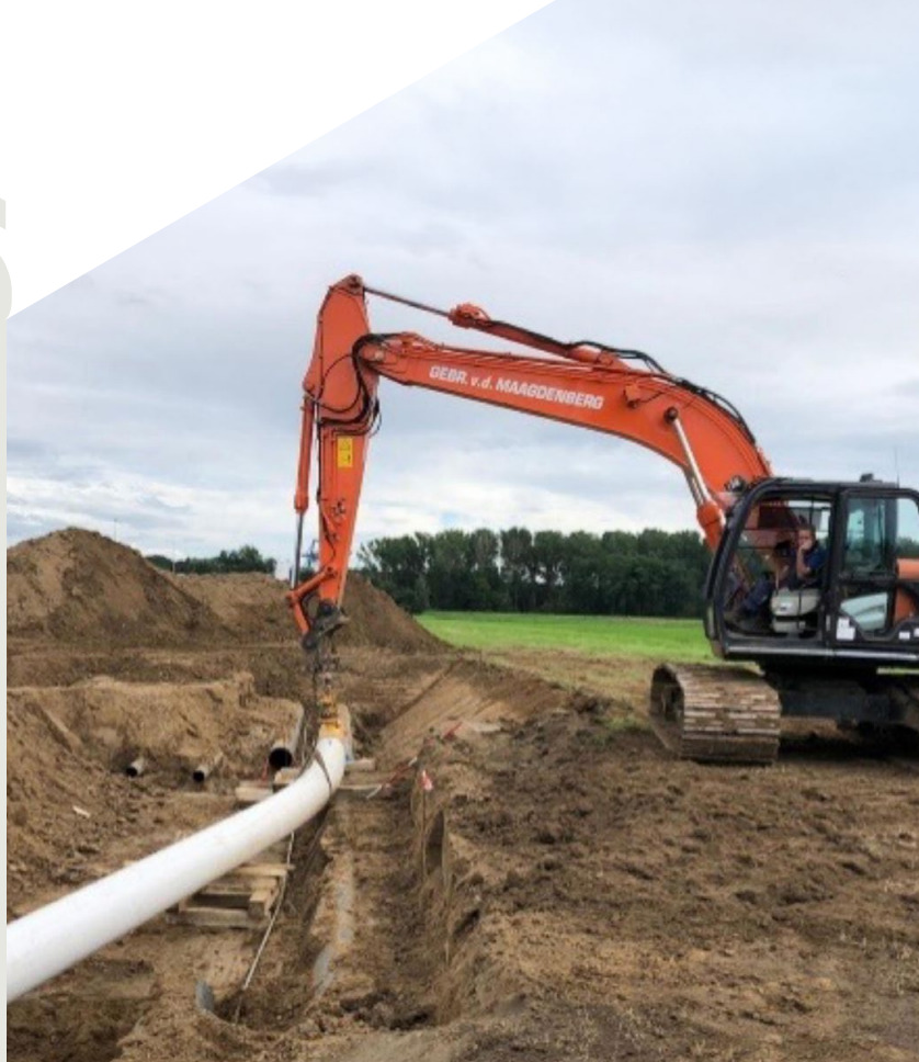
Aanleg leiding in open ontgraving
